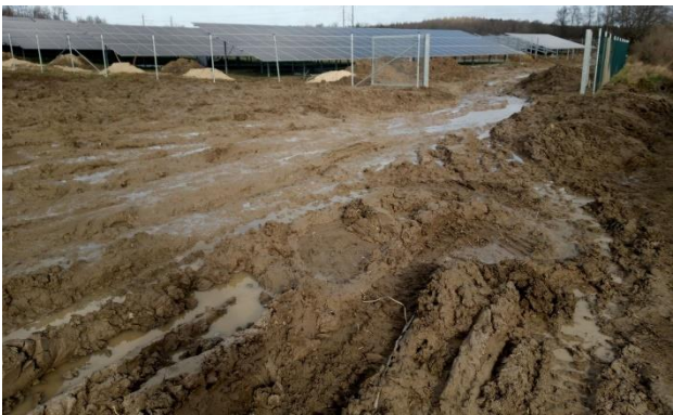
Foto 1-3: Befahrung ungeschützten Oberbodens bei ungeeigneter Witterung/Bodenfeuchte führt zu Schädigung des Bodengefüges und schränkt die Funktionsfähigkeit des Bodens ein
