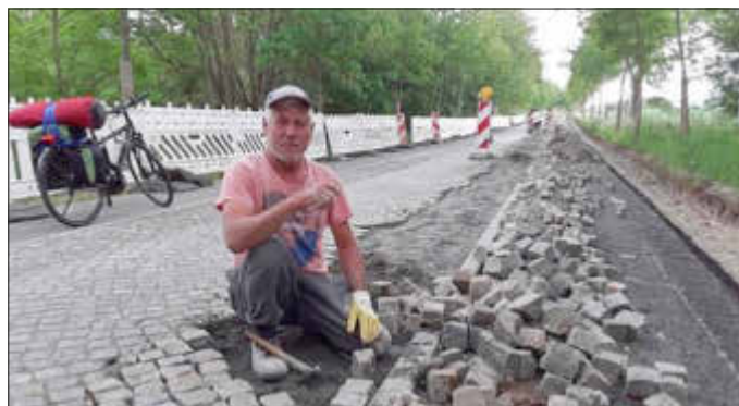
Pflasterarbeiten in Stralsund in Richtung Brandshagen
