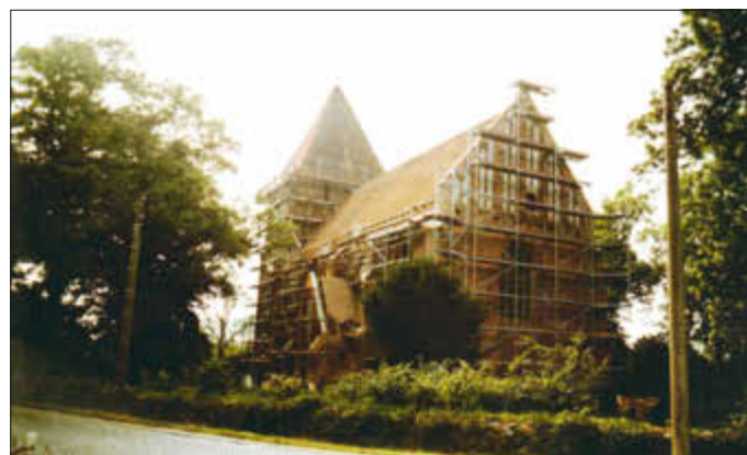
Kirche Süd Ost eingerüstet
