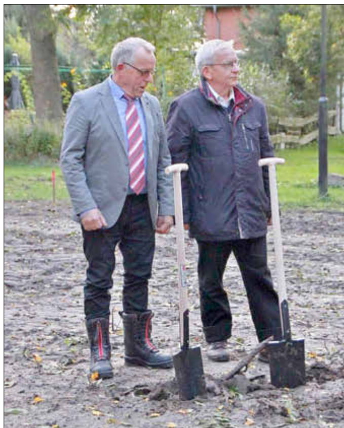
Bürgermeister Siegfried Krüger (l.) und sein Amtsvorgänger Jörg Zimmermann beim ersten Spatenstich für das „Kommunale Mehrzweckgebäude“.
