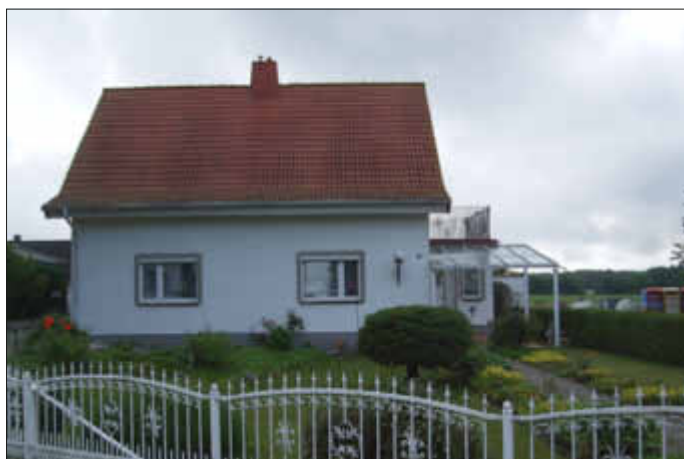
Das Wohnhaus der Familie Kühnel in der Gartenstraße
