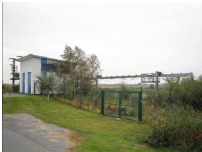
rekonstruiertes Schöpfwerk Groß Kordshagen
