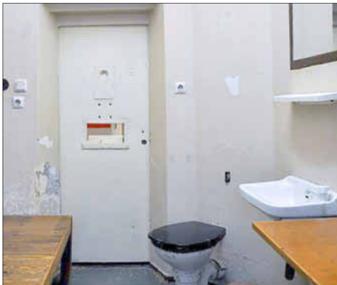
Innenansicht einer Zelle der Stasi U-Haft Rostock, in der auch Detlef Chilla inhaftiert war Foto: BStU
